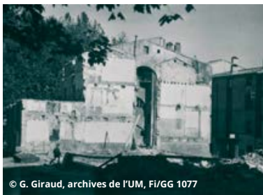
Démolition en vue de l'agrandissement de l'Institut de biologie, 1958
