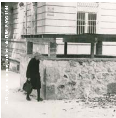
Poste de mitrailleur, bd Henri IV, près du square de la Tour des pins vers 1940
