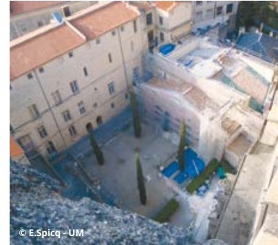
Réfection des toitures du theatrum anatomicum
